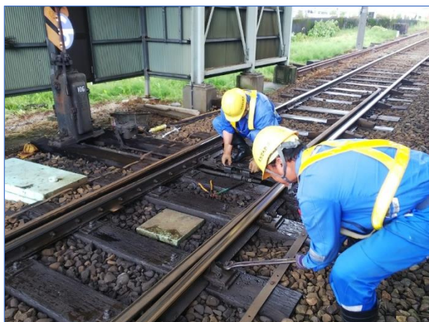
〔電気〕 電気転てつ機の精密検査
