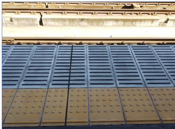
目の不自由な方のホームからの転落防止対策として、線状の突起をつけてホーム中央の方向を知らせる内方線付き点状ブロックを設置しています。
