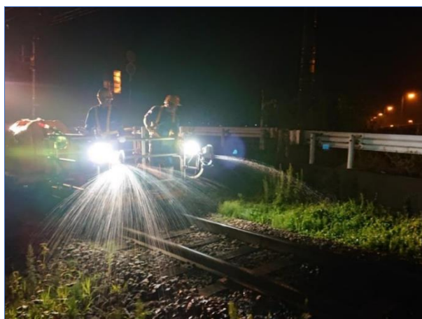
〔線路〕 除草薬の散布
