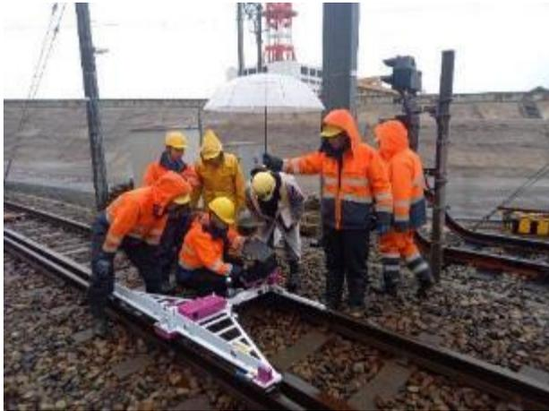
〔電気〕 レーザー式架線測定器導入
