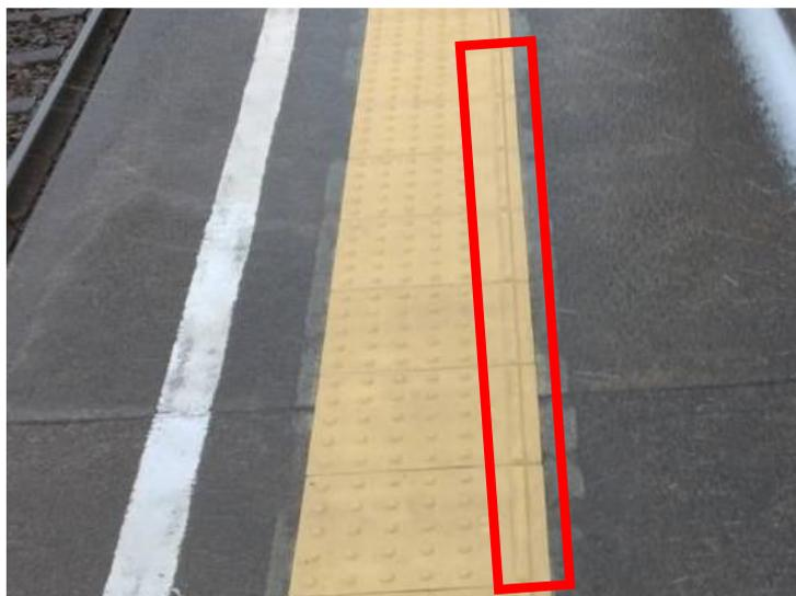
目の不自由な方のホームからの転落防止対策として、線状の突起をつけてホーム内側の方向を知らせる内方線付き点状ブロックを設置しています。
