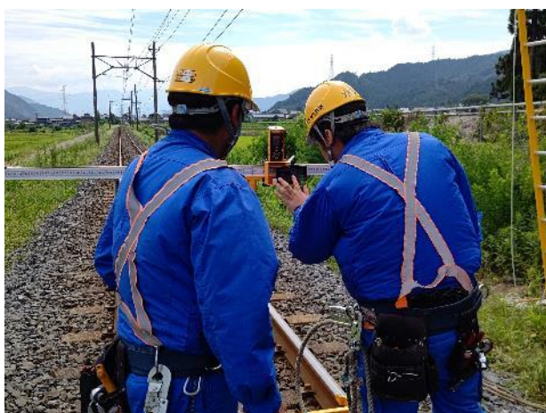
〔電気〕 電車線(トロリ線)の高さ測定
