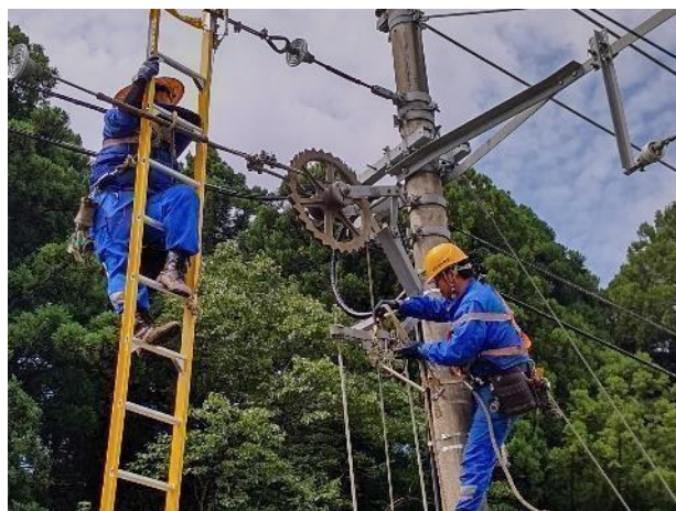
〔電気〕 電車線の張力の調整
