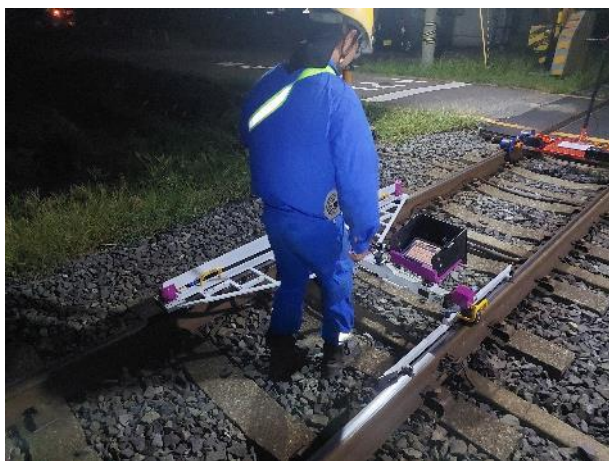
〔線路〕 軌道の検測
